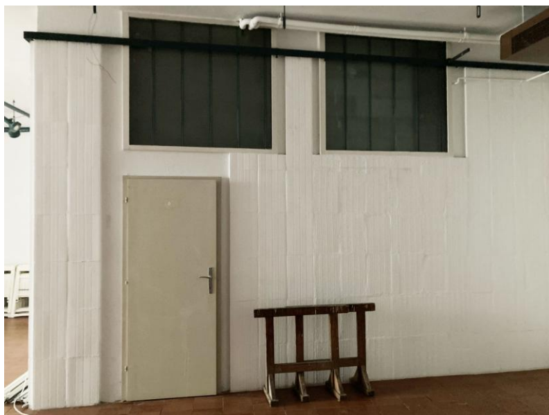
Stena v pritličju, v prostoru 17, kjer se odstranijo vrata in na novo obloži stena s planetami
