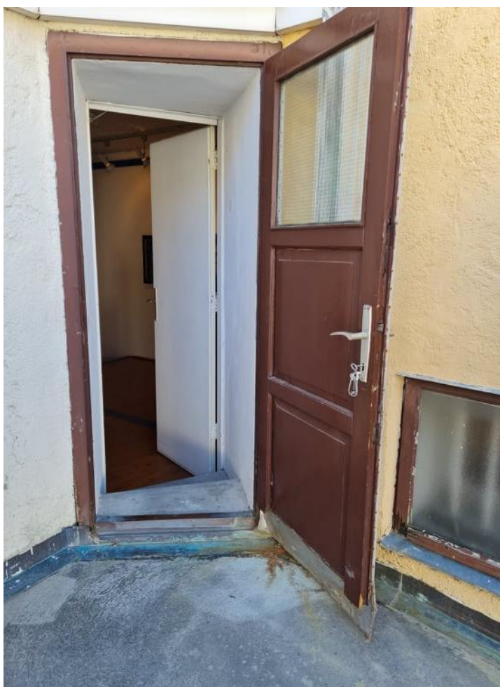
Zunanja vrata, ki vodijo na teraso se skupaj s podbojem naredijo nova po vzoru originala
