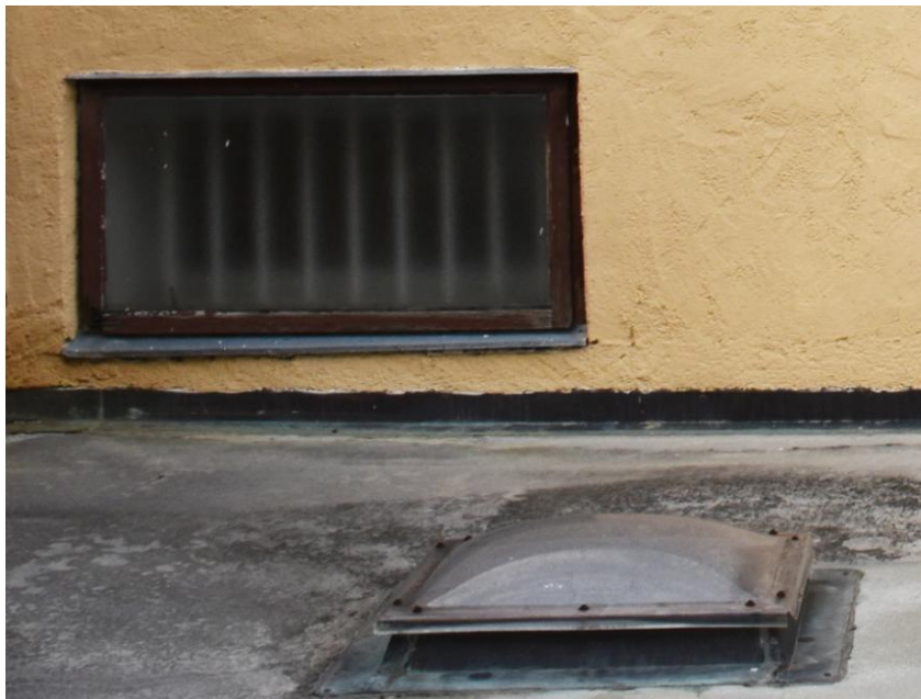
Okno v nadstropju, ki se zamenja in strešna kupola na terasi, ki se zamenja
